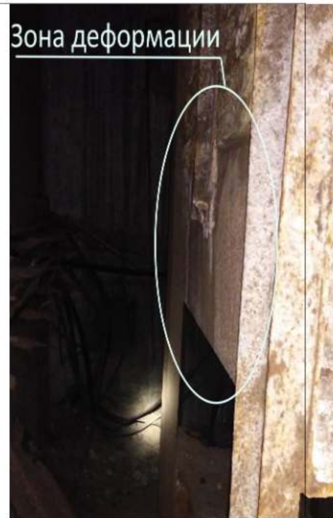
Рисунок 13 – Фотография реальных деформаций подгрузовой балки противовеса ш. Южнодонбасская №1
